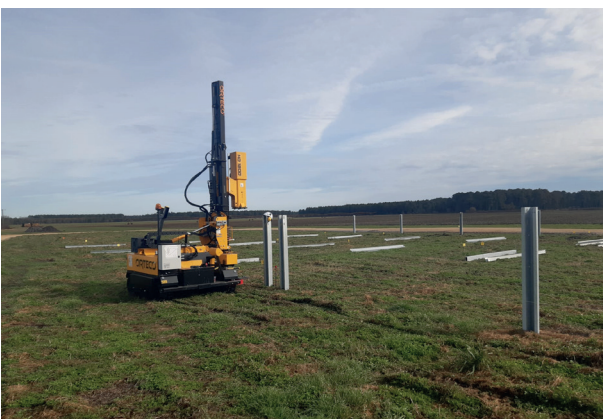
Préparation du terrain - © VALOREM
